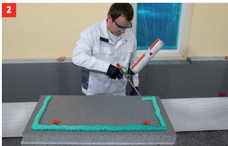
2 Kleberabdeckung der Powersticks entfernen und SOVASPEED Klebeschaum aufsprühen.
