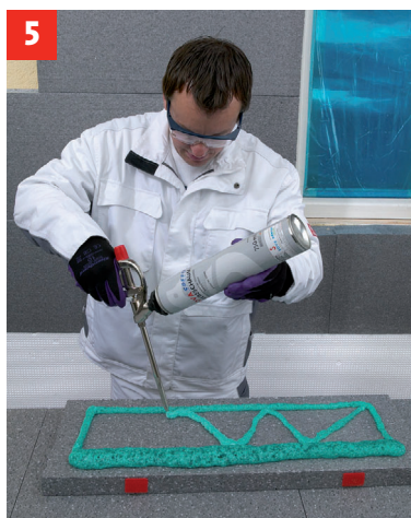
5 Bei der Verarbeitung von Laibungsplatten werden zwei SOVASPEED Powersticks vollständig in die Schmalseiten der Dämmplatte eingedrückt...
